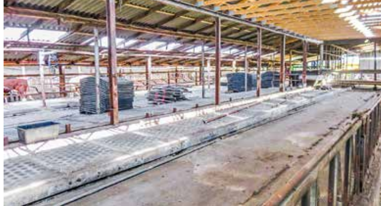
Auch die Nutzung und der Umbau von Altgebäuden werden in den Planungsgesprächen berücksichtigt.
