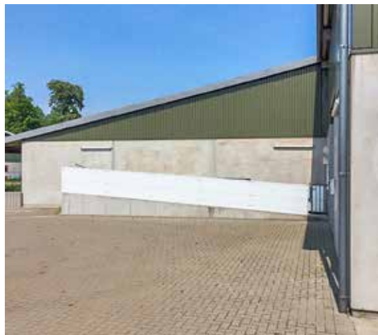
Verladerampen mit seitlichen Kunststoffwänden
