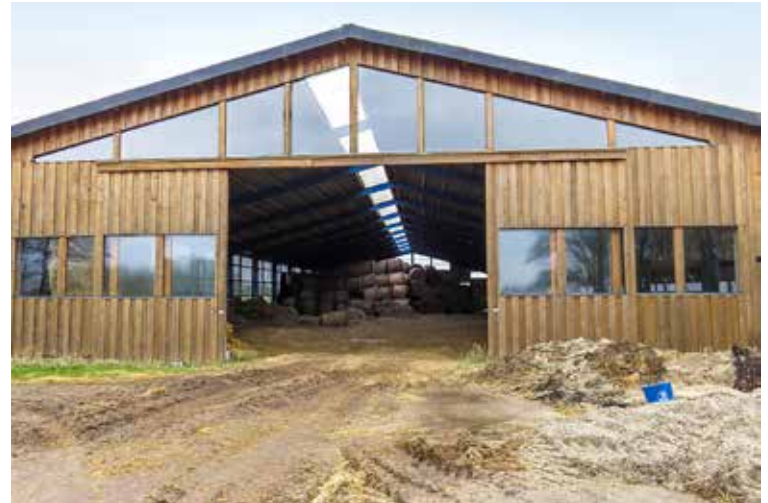
Bei den Arbeitsgruppentreffen werden vorhandene Gebäude und ein möglicher Bauplatz in Augenschein genommen. Fotos (3): Sonja Donicht
